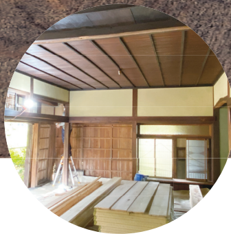
空き家・古民家の 柱・梁の洗浄
